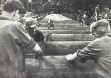
In alto: si sistema il piano a rulli di testa del nuovo blowing a sinistra: una fase di montaggio della gabbia dello Schloemann
